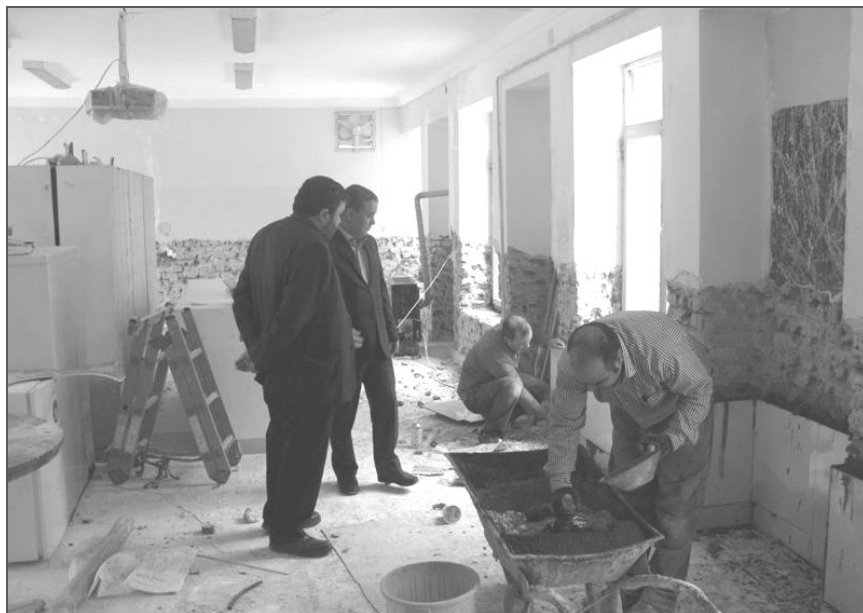
تعمیر دیوار و کف سالن مرکز شماره یک اردبیل
